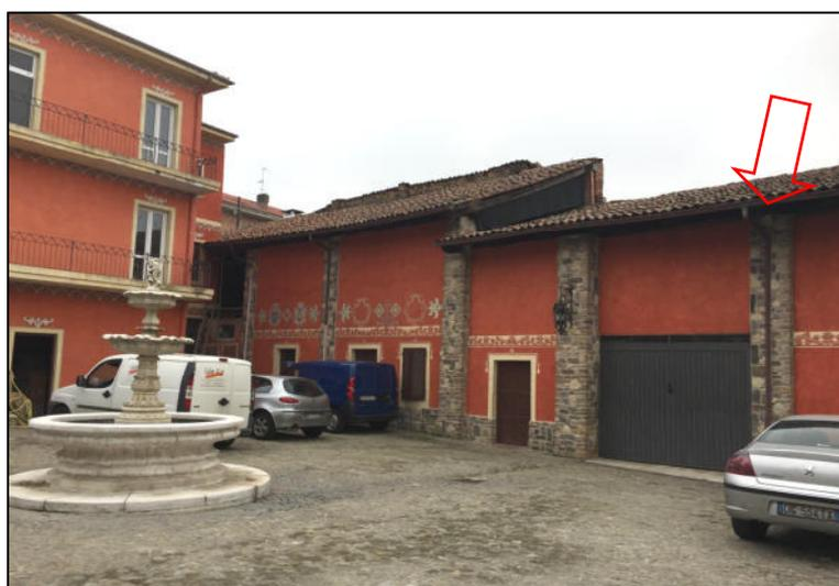
una porzione sarà oggetto di demolizione, senza ricostruzione, creando così un nuovo spazio per i necessari parcheggi; la parte rimanente, anch'essa soggetta a demolizione, sarà interamente ricostruita. La porzione affacciante su Via Italia sarà anch'essa demolita sino alla quota della soletta recentemente ricostruita.
