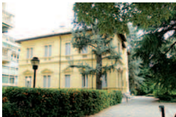
Villa Scalcarozzi, storica sede di Aov
